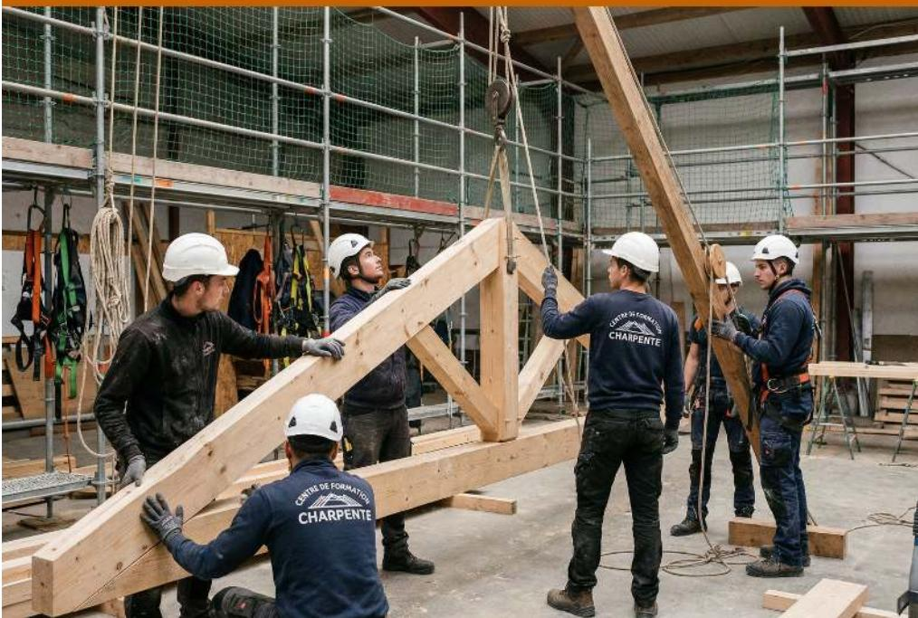
*Lever une ferme avec une chèvre nécessite une coordination minutieuse et des EPI appropriés*
